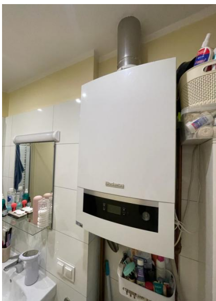
Rys. 7 Źródło ciepła – kocioł gazowy
