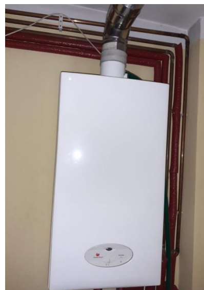
Rys. 10 Źródło ciepła – kocioł gazowy
