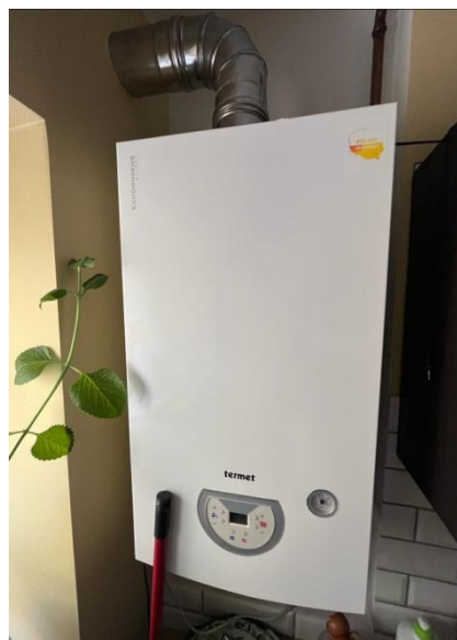
Rys. 8 Źródło ciepła – kocioł gazowy
