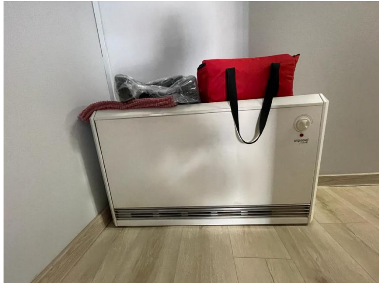
Rys. 11 Źródło ciepła – grzejnik elektryczny
