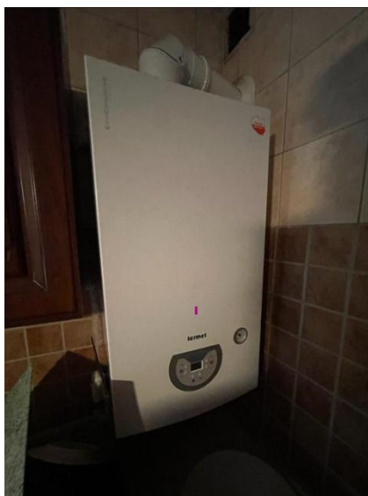
Rys. 9 Źródło ciepła – kocioł gazowy
